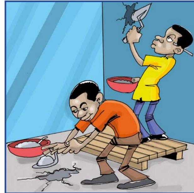
Colmatez toutes les fissures et les crevasses du sol et des murs avec du ciment, vérifiez que le toit ne fuit pas.
