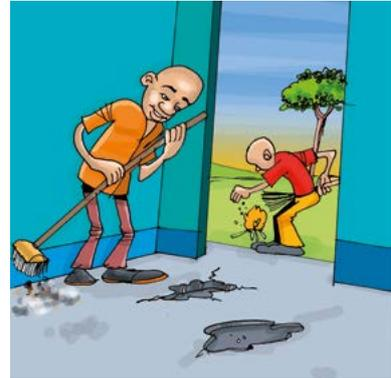
*Assurez-vous que le sol est en bon état* - Le sol doit être soigneusement inspectés pour détecter les fissures et le cas échéant doivent être colmatés avec du ciment. Les fissures dans les murs doivent également être colmatées.
